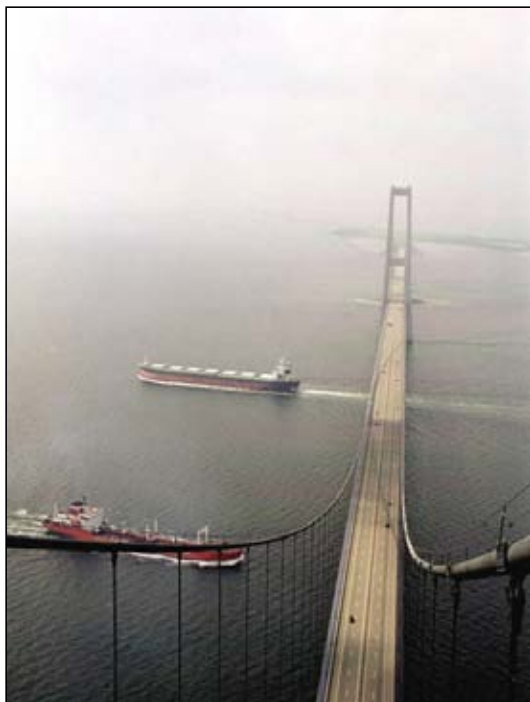
De 2 motorveje på Storebælt Foto: Peter Dam, VTS
